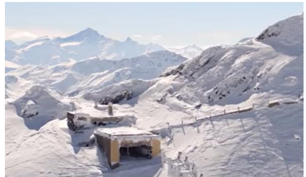
Bergstation der bestehenden Seilbahn auf den Westberg
